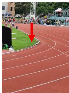
Obr. 5 Chybějící kužele v místech přechodů rovných úseků do zakřivených
